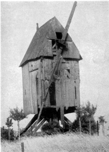
*Bockwindmühle auf dem Stemmer Berg ca. 1934. Bei der Bockwindmühle wurde der gesamte Mühlenkorpus mit Hilfe eines langen, an der Rückseite befestigten „Steert“ in den Wind gedreht.*
